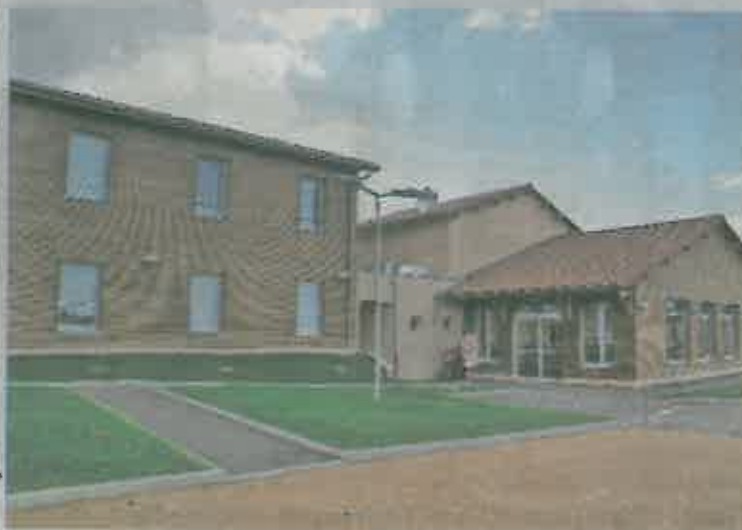
Le 5 novembre dernier, la MFR de Villié Morgon inaugurait un nouveau bâtiment de 850 m 2 abritant une nouvelle cuisine, une nouvelle salle de restauration et l'internat pour les filles. L'ancien réfectoire abrite aujourd'hui l'animalerie pédagogique qui a été entièrement réaménagée.
